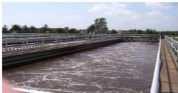
บ่อบำบัดน้ำเสีย
