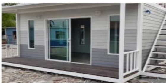
บ้านประกอบเสร็จ
