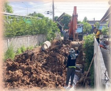
โครงการวางท่อระบายน้ำพร้อมบ่อพัก หมู่ที่ ๑๑
